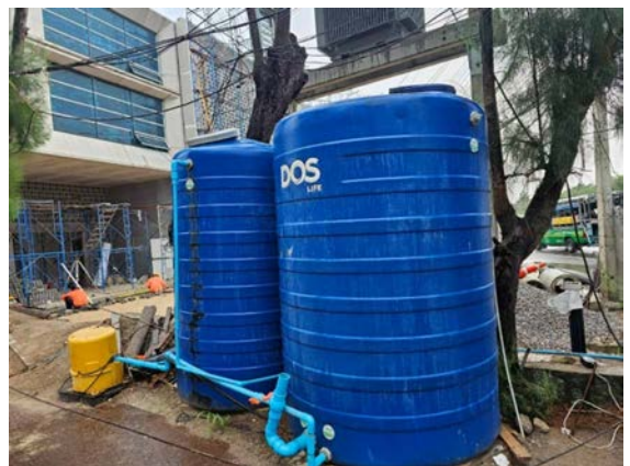
รูปที่ 2-21 ถังเก็บน้ำสำรอง
