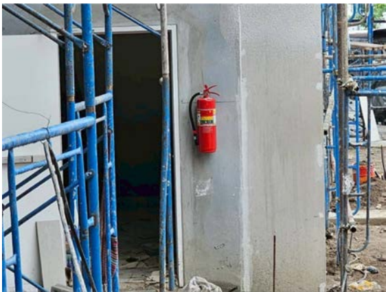
รูปที่ 2-36 ถังดับเพลิงเคมีมือถือแบบแห้ง
